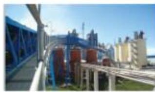
400万吨新型干法电石渣制水泥
